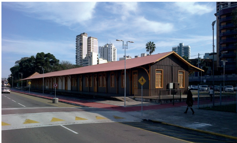
Figura 3: Prédio da antiga Estação Ferroviária, restaurado em 29/7/2016. Fonte: Foto Vitor Hugo Longaro.
