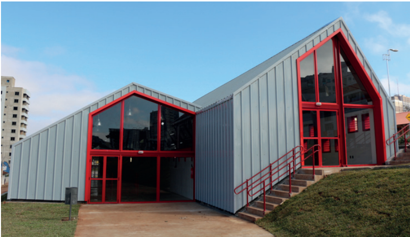
Figura 7: Edifício e a relação com o terreno. Fonte: ArchDaily, 2017.
